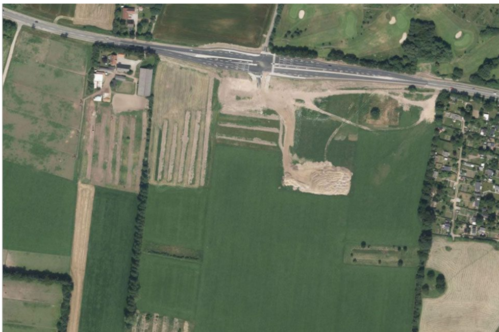
Ortofoto optaget i juli 2013. Der er etableret et kryds hvor den nye stamvej Bygholm Bakker skal tilsluttes Silkeborgvej.
